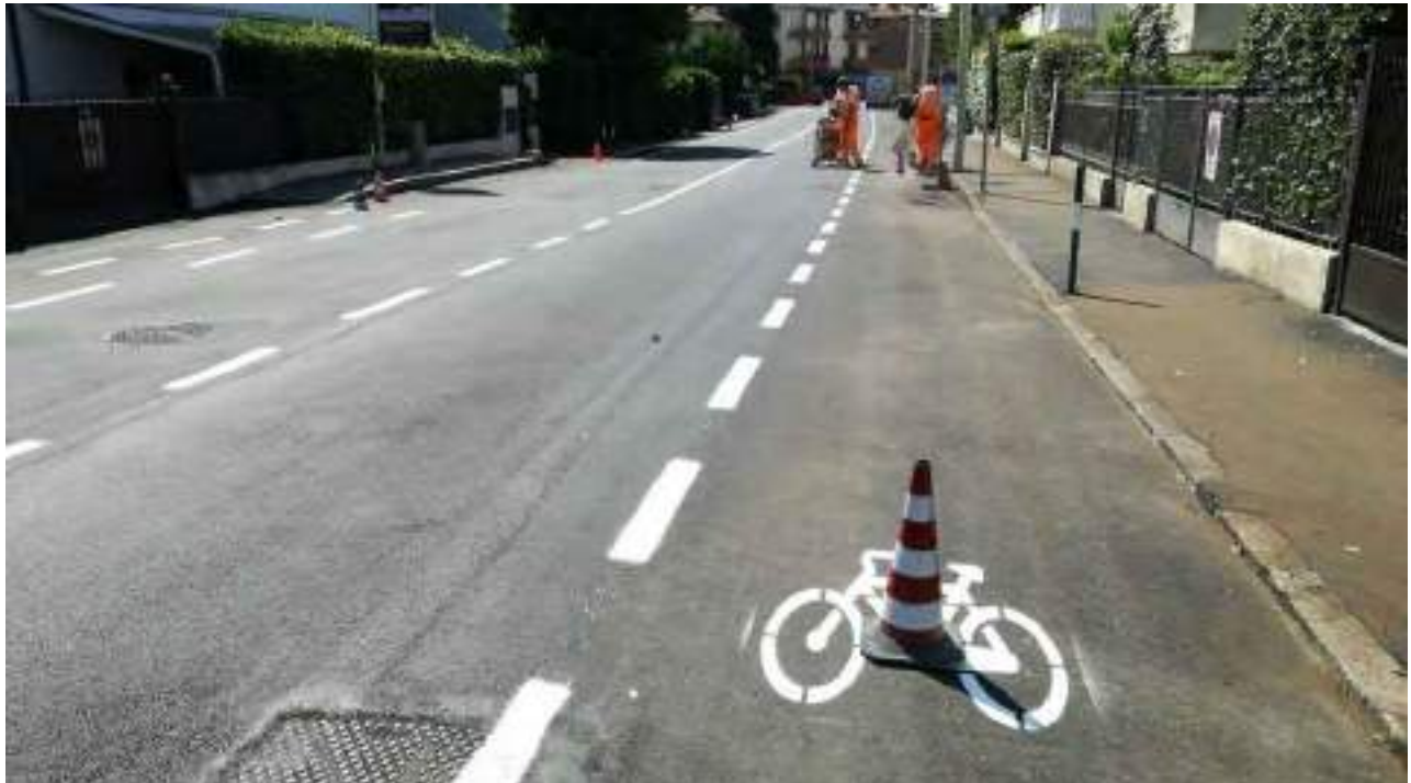
Corsia ciclabile in fase di realizzazione - Padova (limite valicabile)
