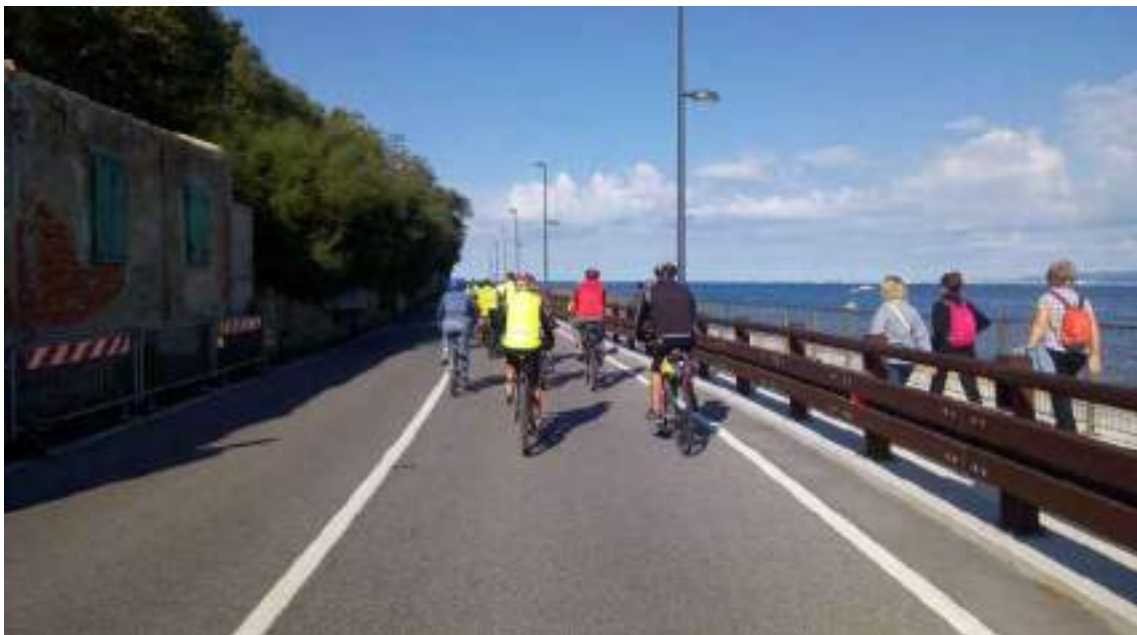
Sperimentazione Costa in festa – A destra pista ciclopedonale promiscua realizzata nei lavori di riqualificazione del primo lotto del tratto Porto San Rocco – Punta Olmi
